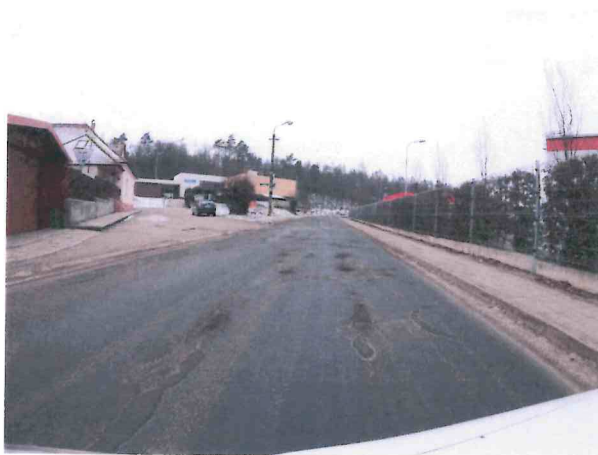
Výtluky, vysprávký, podélné rozvětvené trhliny
