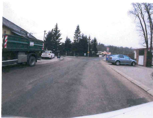
Vysprávký, podélné rozvětvené trhliny
