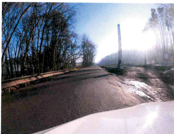
Hl. koroze, plošná deformace vozovky
