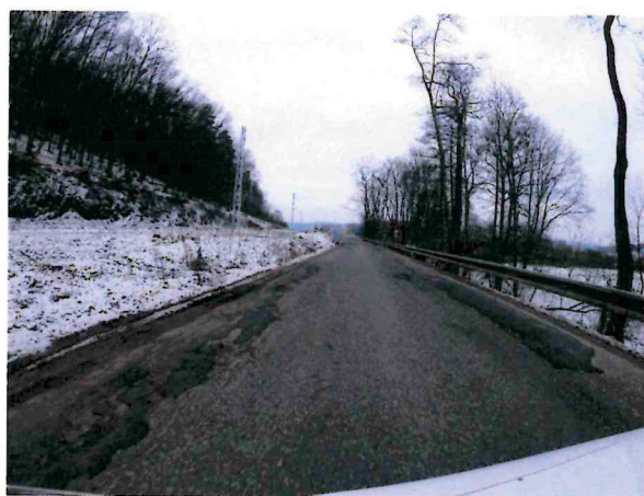
Hl. koroze, vysprávkky, podélné rozvětvené trhliny
