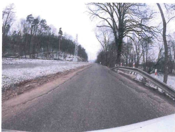
Hl. koroze, vysprávkky, podélné rozvětvené trhliny
